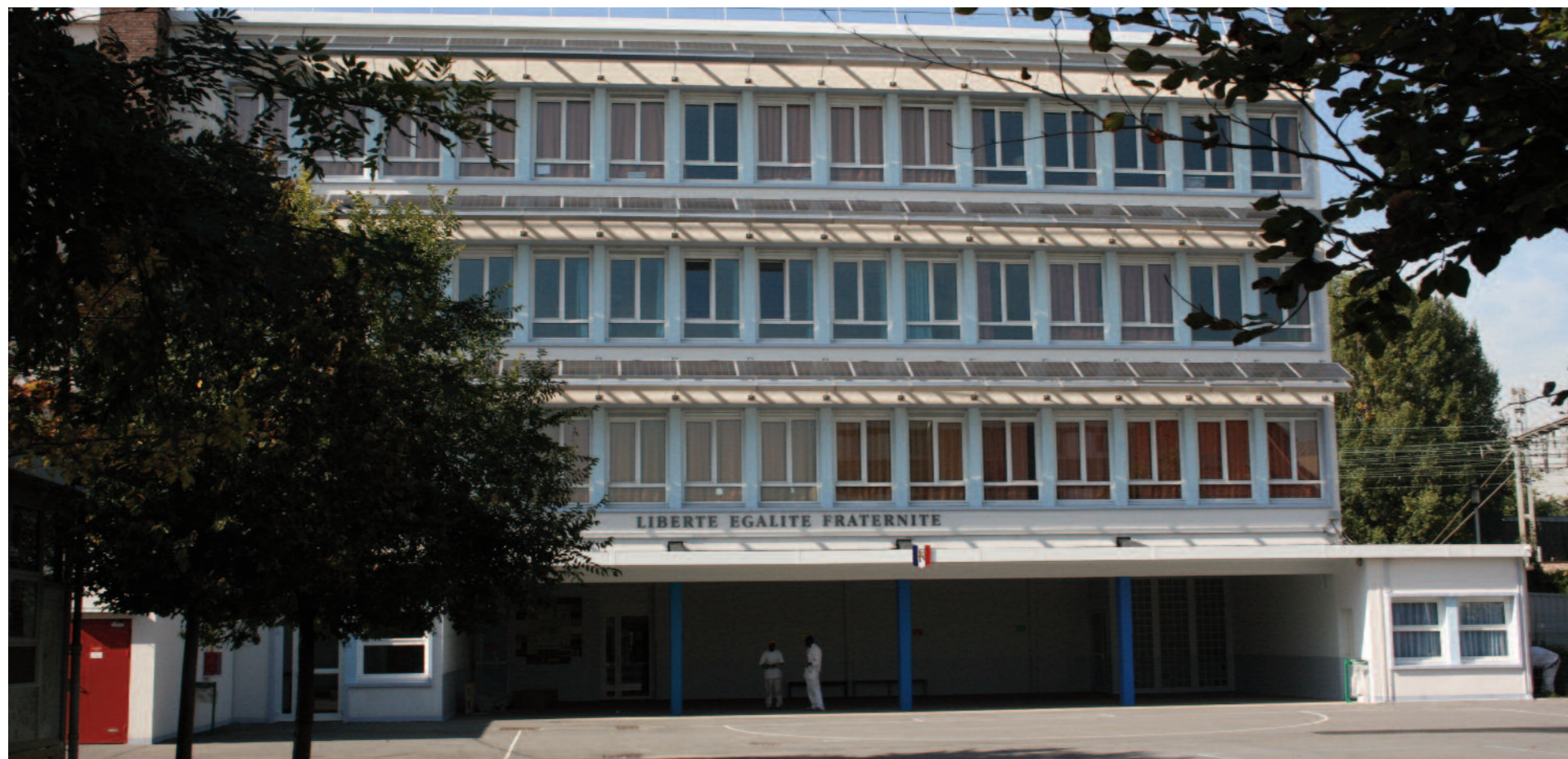
Des panneaux photovoltaïques ont été installés à l'été 2009 sur la façade sud de l'école Michelet.
