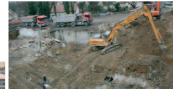
La démolition du bâtiment a commencé en décembre dernier. Un chantier impressionnant !
