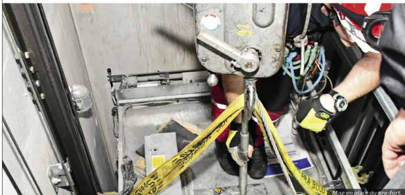
Mise en place du tire-fort.
