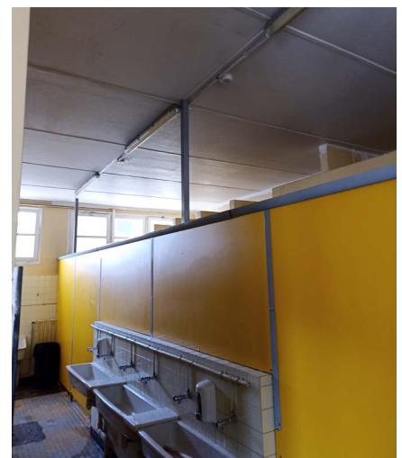
► Peinture des toilettes de l'école Jean Jaurès
