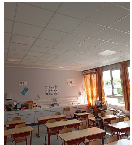
► Pose de faux plafonds dans des classes de l'école Edmond Michelet
