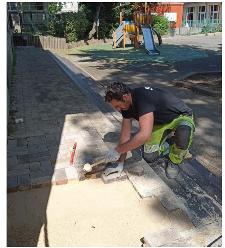
► Pose de pavés autobloquants à la maternelle Jean Jaurès
