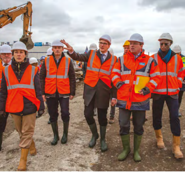
Le Président du Département et le Maire, en visite sur le chantier de la gare.
